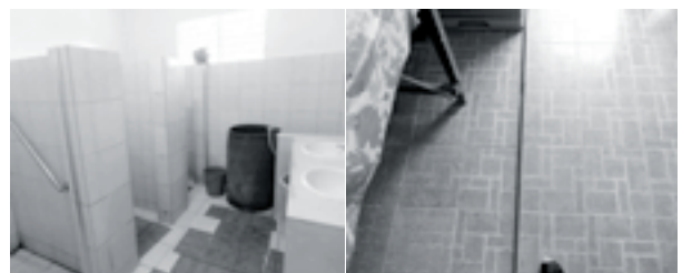
写真4 共同トイレの様子
